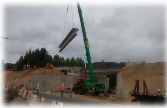
Montaje Vigas Enlace Rotonda Palomares 2, Dm. 69.700
