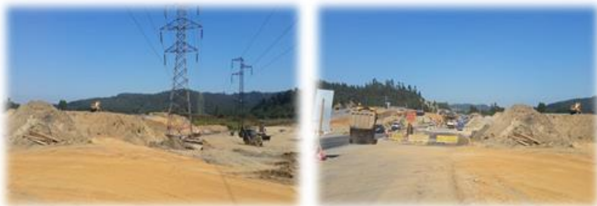
Movimiento de Tierra Enlace Paso Inferior Palomares 2, Dm. 67.820, Sector A
