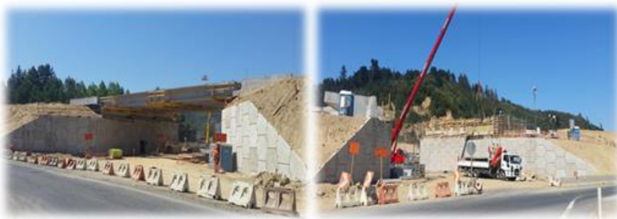
Montaje de Vigas Enlace Paso Superior Palomares I, Dm. 70.000, Sector A
