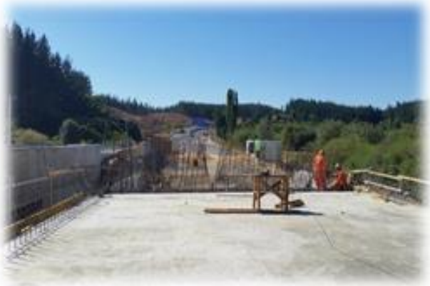
Enfierradura Losa de Transición Puente Cangrejillo Sur, Dm 46.260, Sector A
